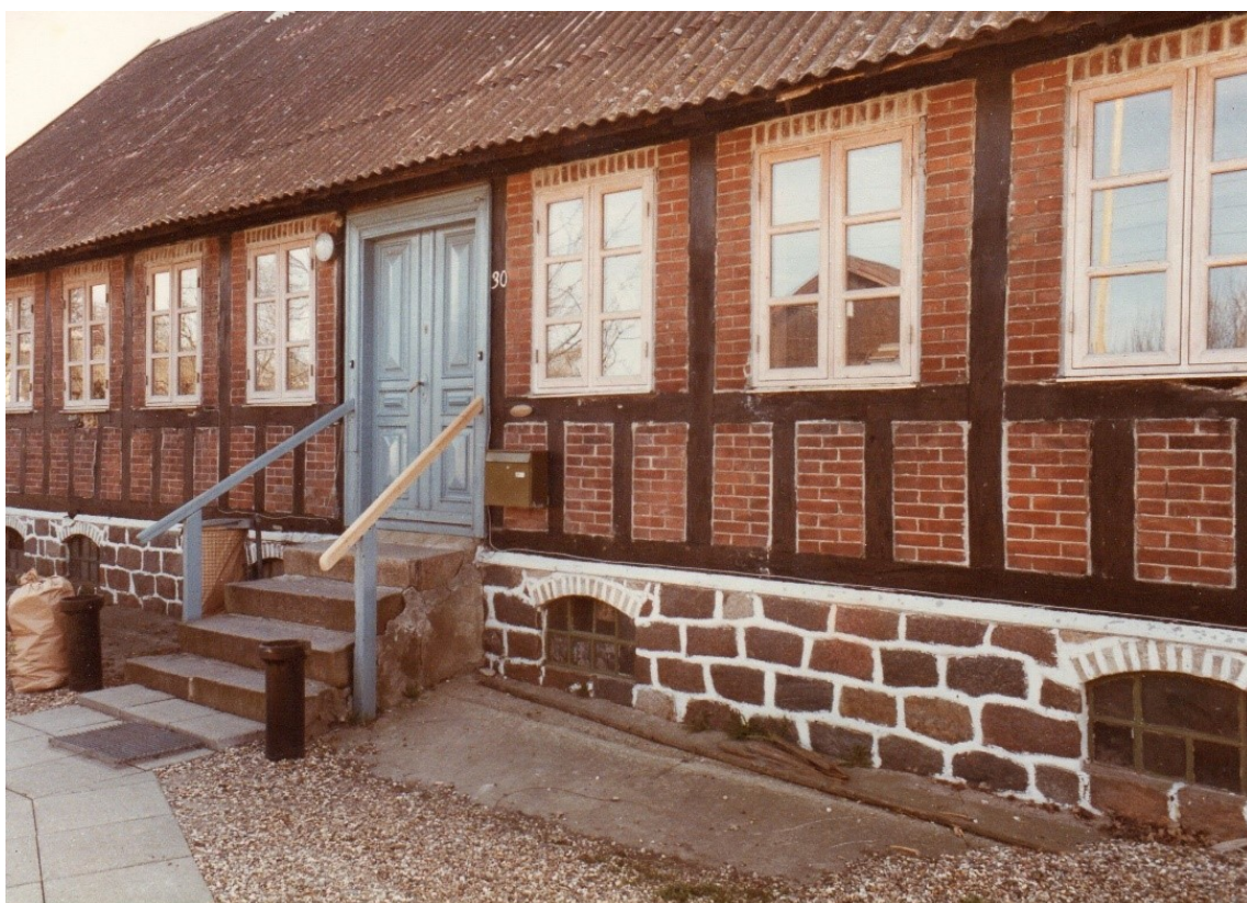
Tilshusets indgangsparti restaureret
